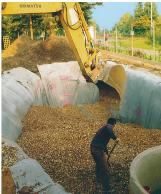
Bau der Regen Rigole.
